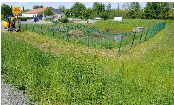
Abb. 5: Böschungen am RRB, 10.05.2024
