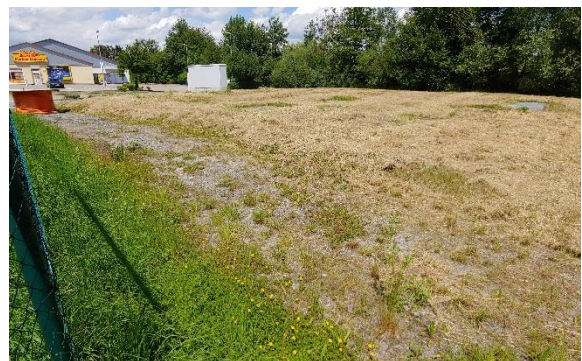
Abb. 6: Gemähte Beckendecke am RÜB, 06.06.2024
